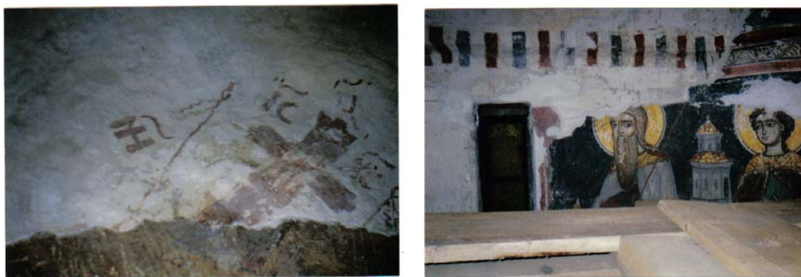
Fig. 9,10. Vederi din turlă, cu stratigrafia frescelor asigurate pentru intervenția structurală.
