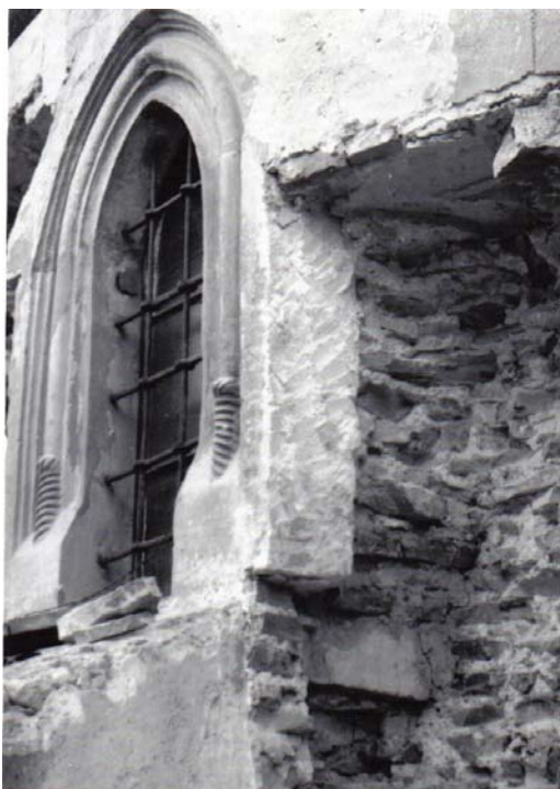
Fig. 3 Aspect din timpul săpării șlițurilor pentru pilastrul de consolidare a zidăriei. (Coconi, Suceava, 1998)
