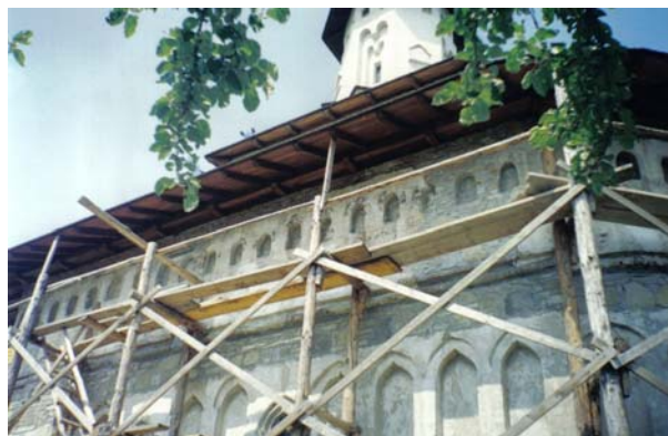
Fig. 5, 6. Aspecte din timpul conservării tencuielilor decorative. (Coconi, Suceava, 1999)
